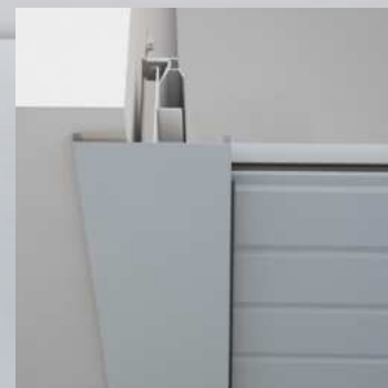
Montaż w otworze - maskownica przed otworem
