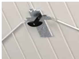
Zamek z wkładką ryglującą bramę dwustronnie
